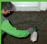
Gruntowanie KÖSTER Polysil® TG 500
