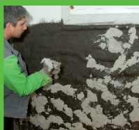
Nakładanie obrzutki renowacyjnej
