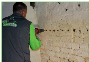
Wiercenie otworów w poziomie
