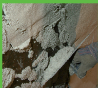
Nakładanie tynku renowacyjnego KÖSTER Sanierputz
