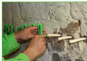
Montaż wałków KÖSTER Kapillarstäbchen i uchwytów mocujących
